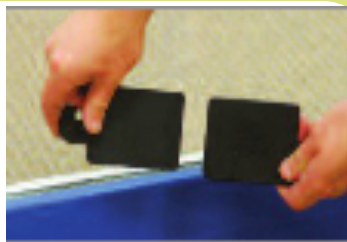
3. povolení a vytažení plastových klínů
