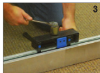
3. dotažení na požadovaný moment
