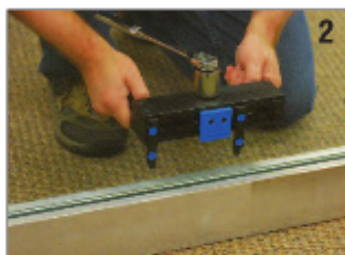
2. nasazení přípravku pro utažení
