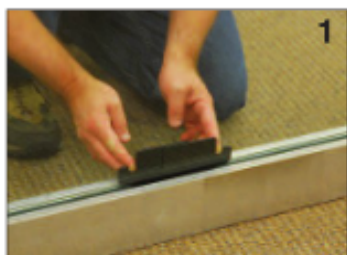
1. vložení plastových klínů do spáry u skla
